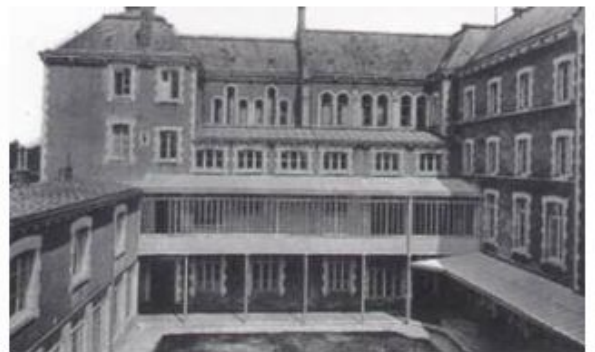
Ci-dessus, la pouponnière vue de la cour intérieure.
